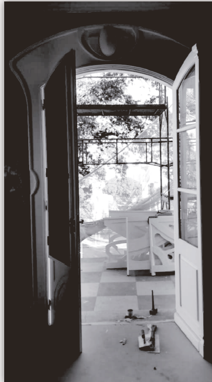
ACOMPANHAMENTO DA OBRA: 11 JUL. 2019
