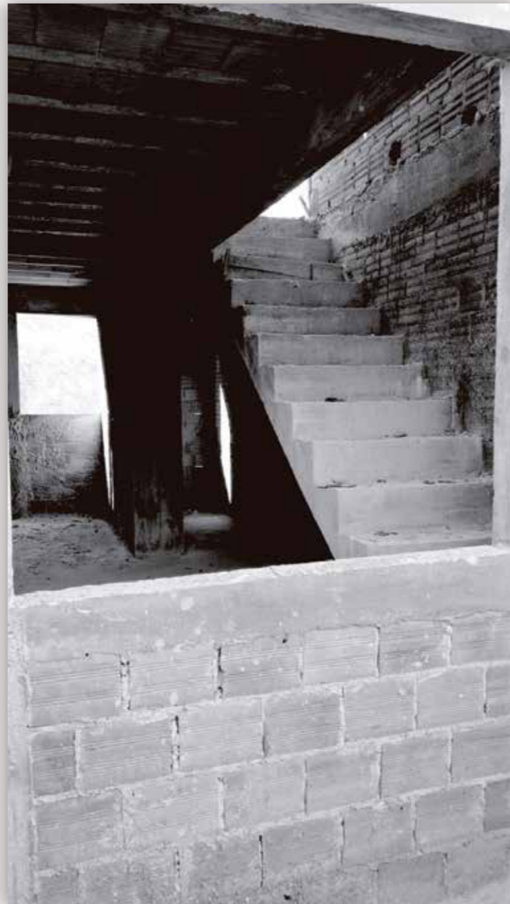
ACOMPANHAMENTO DA OBRA: 25 MAR. 2019
