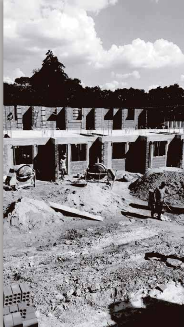
ACOMPANHAMENTO DA OBRA: 25 MAR. 2019
