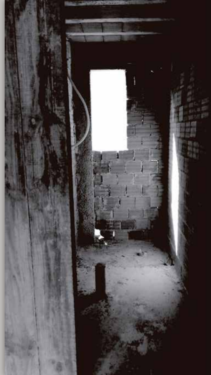
ACOMPANHAMENTO DA OBRA: 25 MAR. 2019
