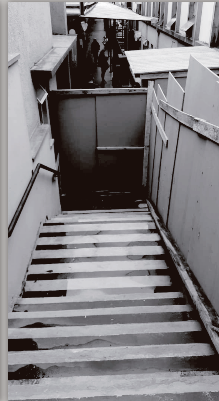
ÍNICIO DAS OBRAS DE ADEQUAÇÃO LOCALIZAÇÃO: RUA DA CIDADANIA, REGIONAL MATRIZ - PRAÇA RUI BARBOSA, CENTRO, CURITIBA-PR.
