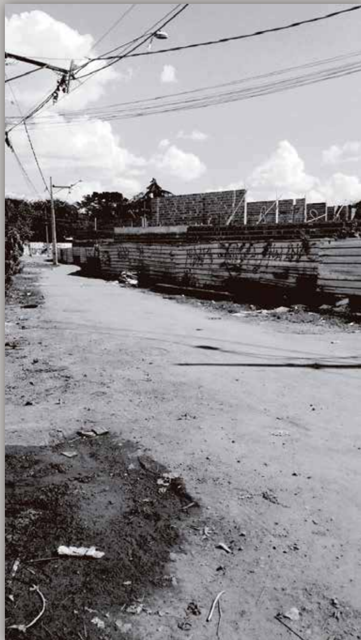
ACOMPANHAMENTO DA OBRA: 25 MAR. 2019
