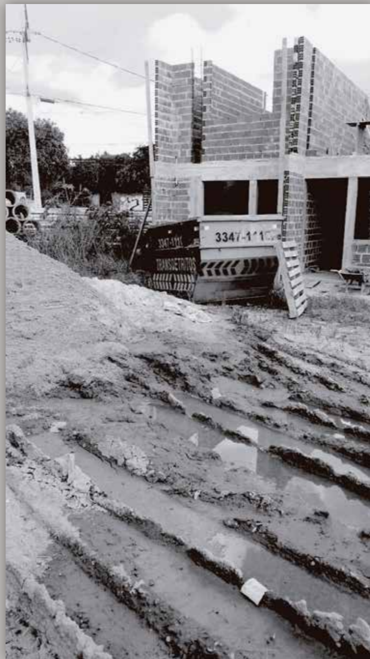
ACOMPANHAMENTO DA OBRA: 25 MAR. 2019
