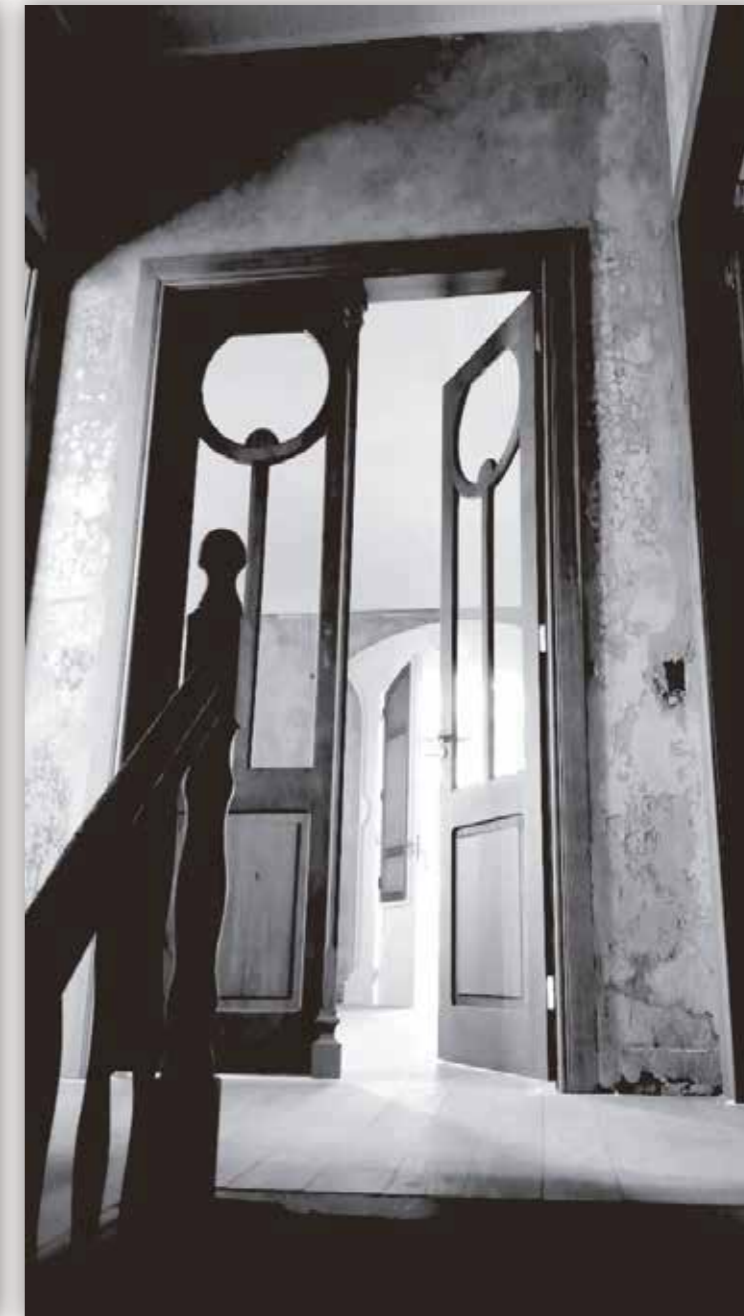
ACOMPANHAMENTO DA OBRA: 11 JUL. 2019
