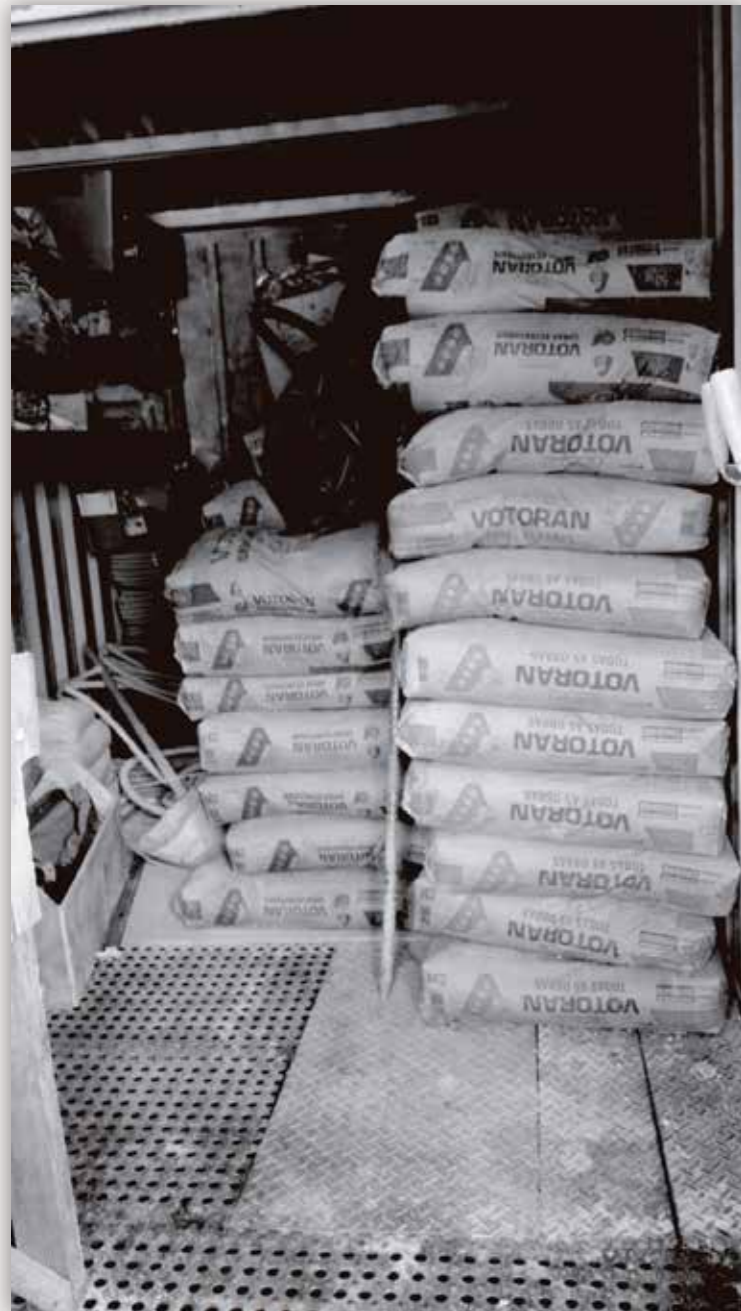
ACOMPANHAMENTO DA OBRA: 25 MAR. 2019
