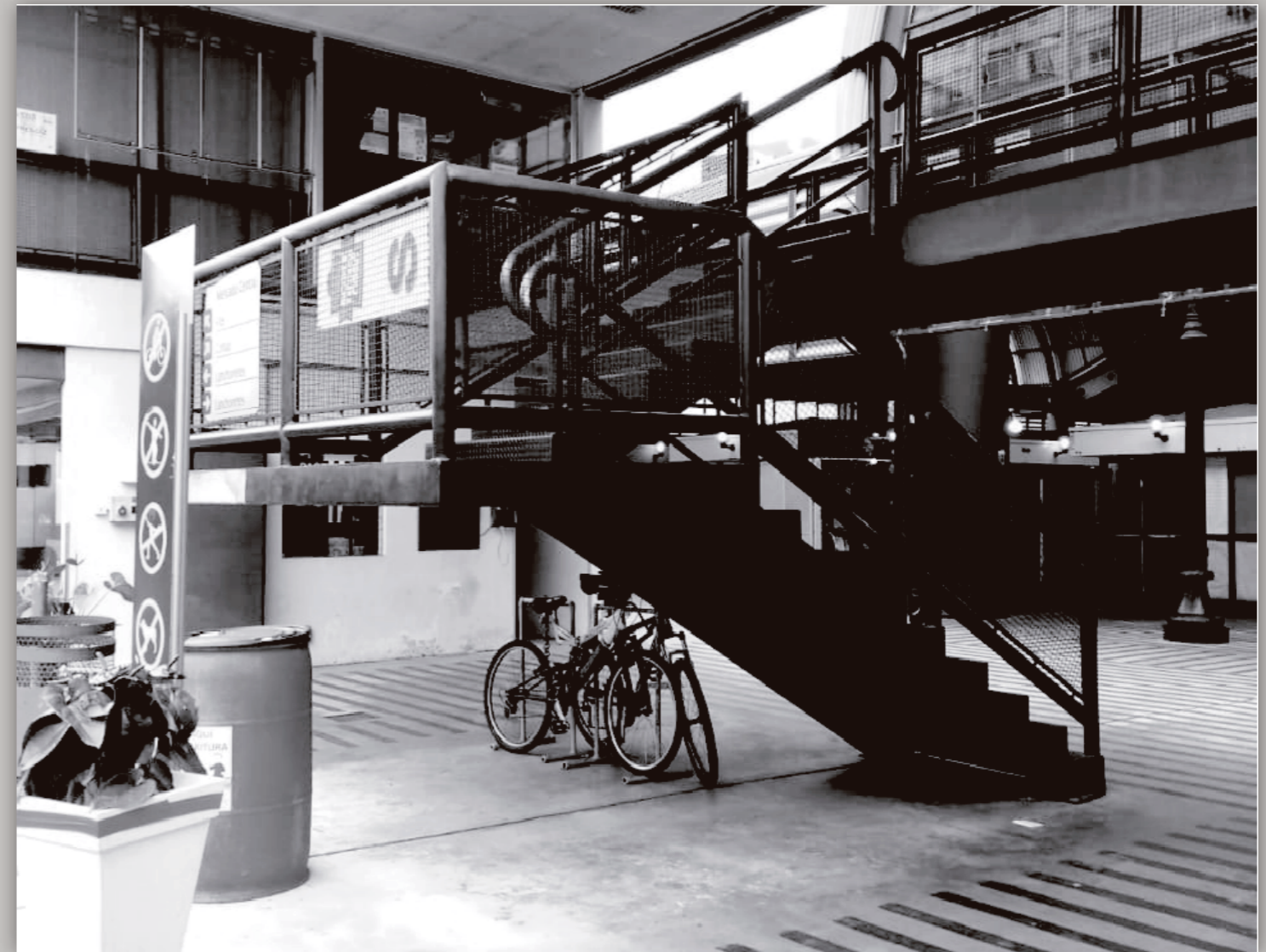
ÍNICIO DAS OBRAS DE ADEQUAÇÃO LOCALIZAÇÃO: RUA DA CIDADANIA, REGIONAL MATRIZ - PRAÇA RUI BARBOSA, CENTRO, CURITIBA-PR.
