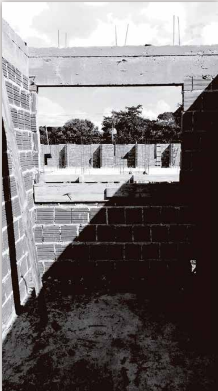
ACOMPANHAMENTO DA OBRA: 25 MAR. 2019
