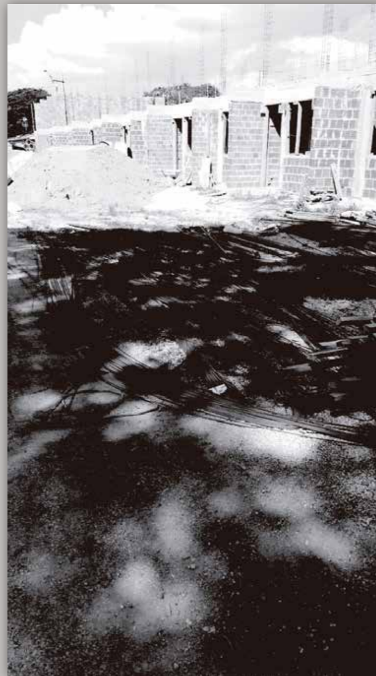
ACOMPANHAMENTO DA OBRA: 25 MAR. 2019
