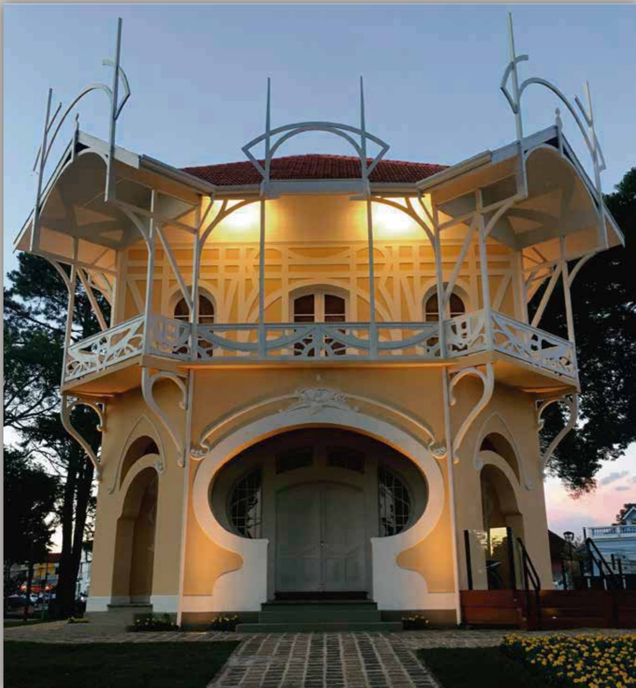
OBRA CONCLUÍDA: REINAUGURAÇÃO 08 DEZ. 2019 IMAGEM: 22 DEZ. 2019
