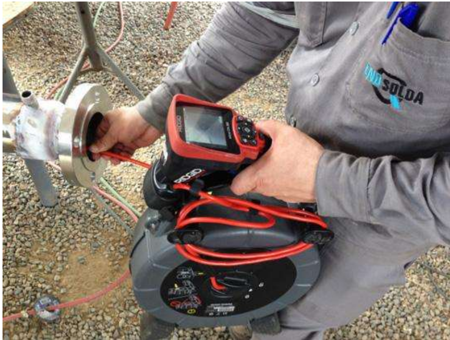
Aparelho de endoscopia industrial utilizado em inspeção de tubulação.
